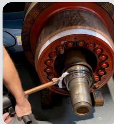
Estrazione di anelli su motore elettrico: - Induttore ad anello L20/D200 - Powerduction 220LG
